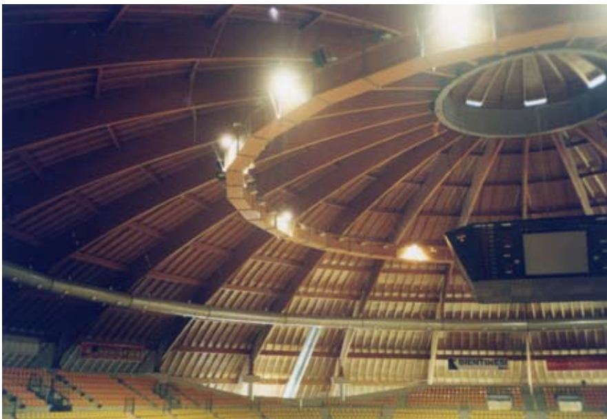
2. Struttura interamente realizzata di legno lamellare incollato con fondazioni di calcestruzzo e collegamenti di acciaio (Palasport di Livorno, realizzazione Holzbau)
