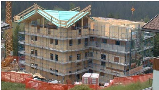
Figura 1. Edificio a struttura di legno di 4 piani realizzato con il sistema XLam (per gentile concessione della RASOM Holz&Ko).
